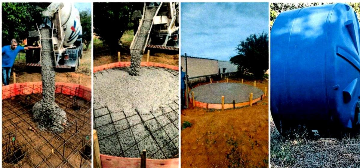
Construção de alvenaria para troca da Caixa d'água do Abrigo
