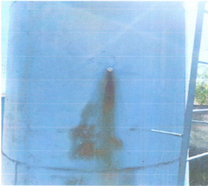
Fotos: Mostrando vazamentos, furos causados por ferrugem
