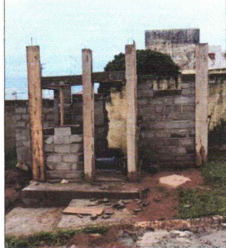
Foto 31: Portaria (Guarita): Em construção – Dez/22
